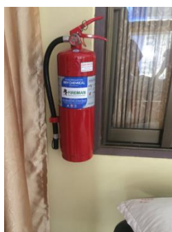
รูปที่ 7. การติดตั้งถังดับเพลิง
