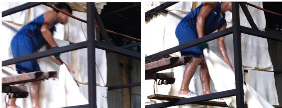
รูปที่ 18 ลำเลียงยางชั้นบน (ชั้นตอนที่ 7)
