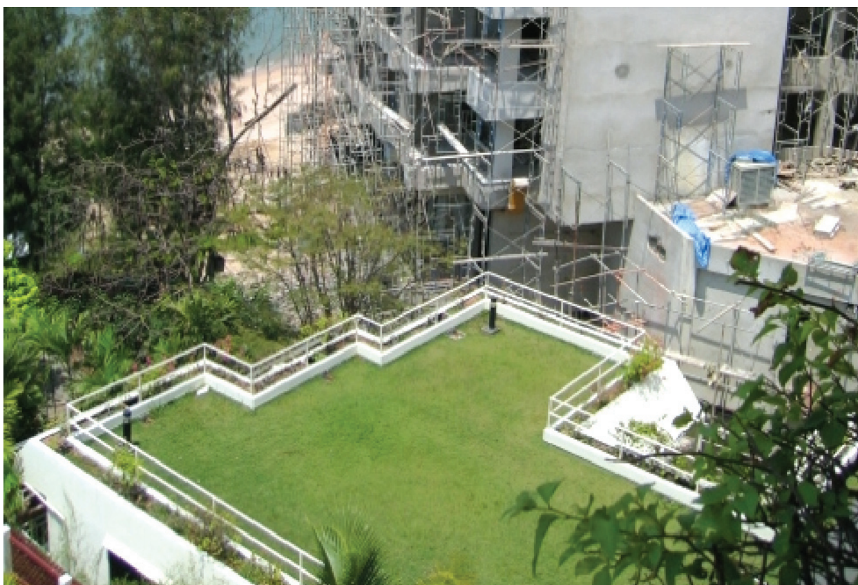
รูปที่ ๑๔ สนามหญ้าดาดฟ้าของการ์เด้นคลิฟคอนโดมิเนียม พัทยา (พ.ศ. ๒๕๒๔) ทำขึ้นเพื่อแทนแบบอาคารหลังคาเอียงที่บังวิวทะเลของชั้นโมสตรและสระว่ายน้ำและแลดูไม่สวยงามเมื่อมองจากอาคารสูงในโครงการเดียวกัน จัดเป็นหลังคาเขียวประเภทกึ่งดูแล
