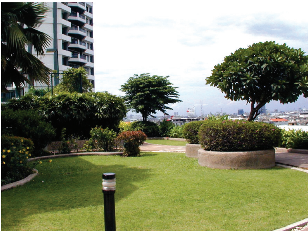
รูปที่ ๑๕ ภูมิทัศน์หลังคาที่สร้างบนดาดฟ้าอาคารจอดรถชั้น ๕ ของตริทศ มารินา กรุงเทพฯ (พ.ศ. ๒๕๓๕) เพื่อเป็นที่พักผ่อนของผู้ใช้อาศัย จัดเป็นหลังคาเขียวได้ในประเภทดูแลมาก
