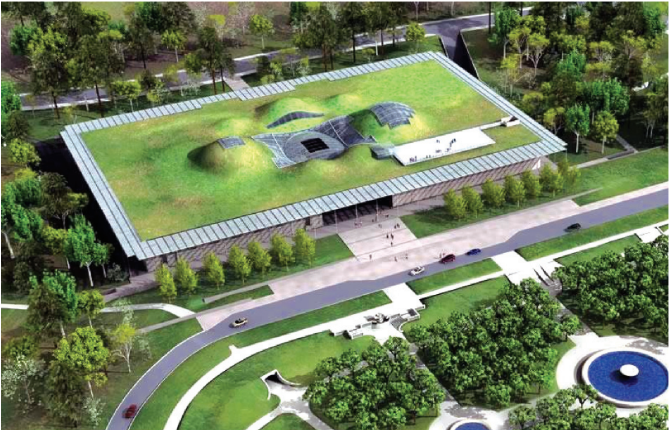
รูปที่ ๑ สถาบันวิทยาศาสตร์แห่งแคลิฟอร์เนีย (The California Academy of Sciences) เปิดเมื่อ พ.ศ. ๒๕๕๑ มีหลังคาเขียวขนาด ๒ สนามฟุตบอลกับแผงผลิตไฟฟ้าจากแสงแดด (รอบชายคา) รวมกันแล้วสามารถลดการปล่อย CO 2 ได้มากถึงปีละ ๑๘๕ ตัน
