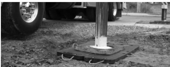
ภาพที่ 10 การใช้แผ่นรองรับเพื่อกระจายน้ำหนักลงพื้นดิน
