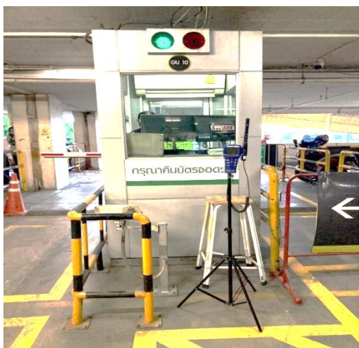
ภาพที่ 1 การติดตั้งเครื่องการตรวจวัดก๊าซคาร์บอนมอนนอกไซด์ในพื้นที่ปฏิบัติงานของพนักงานรักษาความปลอดภัย
