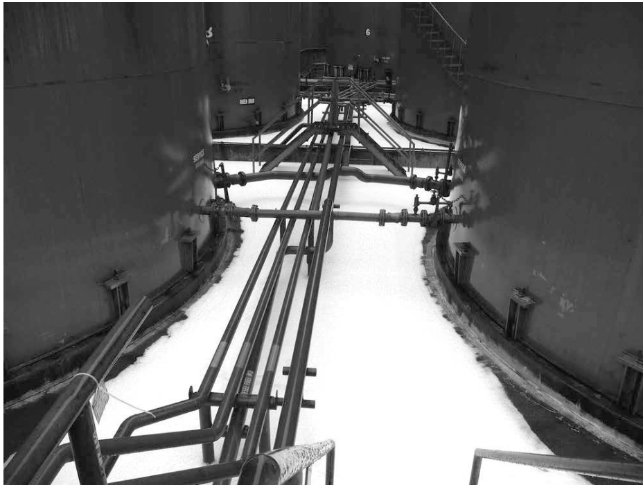
ภาพที่ 1 การปกคลุมผิวหน้าของเหลวไวไฟด้วยฟองโฟมดับเพลิง
