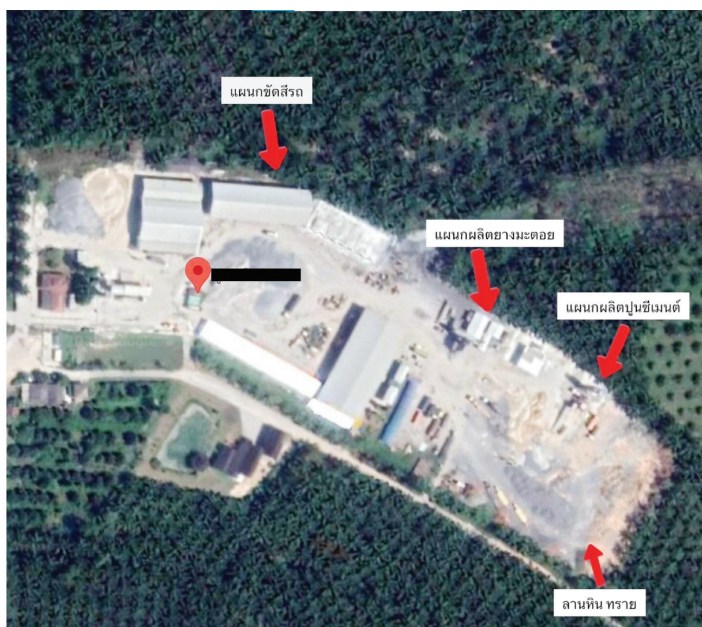
ภาพ 1 แสดงบริเวณพื้นที่ปฏิบัติงานบริษัทรับเหมาก่อสร้างถนนคอนกรีต
