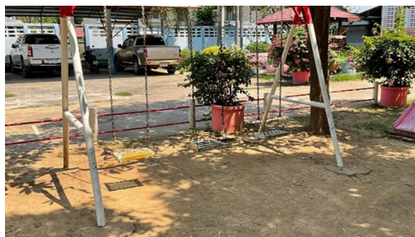
ภาพ 8 ซิงค์ที่มีระยะปลอดภัยด้านหน้าด้านหลังน้อยกว่า 2 เท่าของความสูงซิงค์
