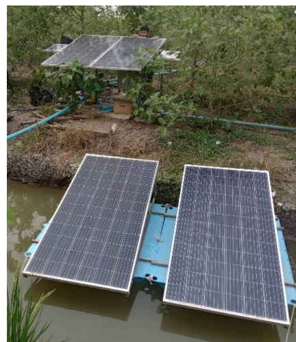
ภาพ 3 การต่อวงจรและติดตั้งแผงเซลล์แสงอาทิตย์ (ก) ไดอะแกรมการต่อวงจรไฟฟ้า (ข) ภาพถ่ายการติดตั้งแผงบนสันร่องและลอยในร่องน้ำ
