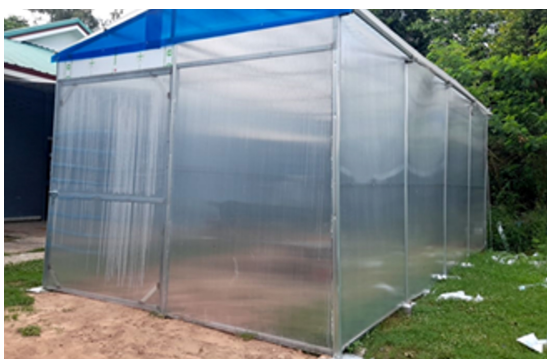
ภาพ 2 พัฒนาออกแบบสร้างโรงเรือนปิดที่ใช้สำหรับการปลูกผักไฮโดรโปนิคส์ในแนวตั้ง
