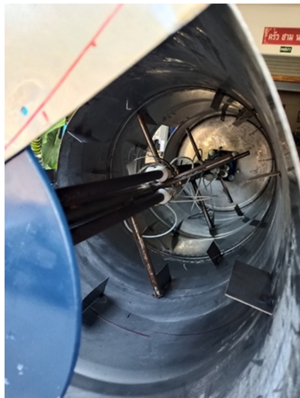
ภาพ 11 การติดตั้ง Heater
