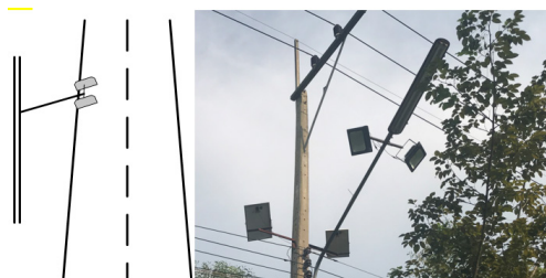
ภาพ 17 การติดตั้งหลอด LED ขนาด 100 W แบบโคมคู่มือมีแขนยื่น
