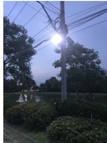
ภาพ 8 การติดตั้งโคมไฟ LED
