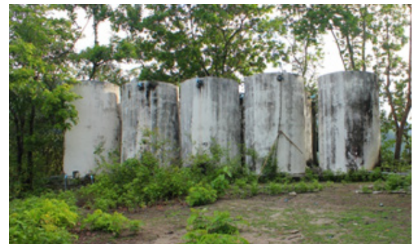
(ข) ถังเก็บน้ำชุมชน
